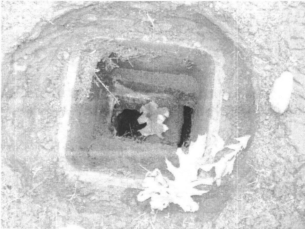
Septic Tank Inlet 7 Trillium Way Amherst, MA 02.02.2012
