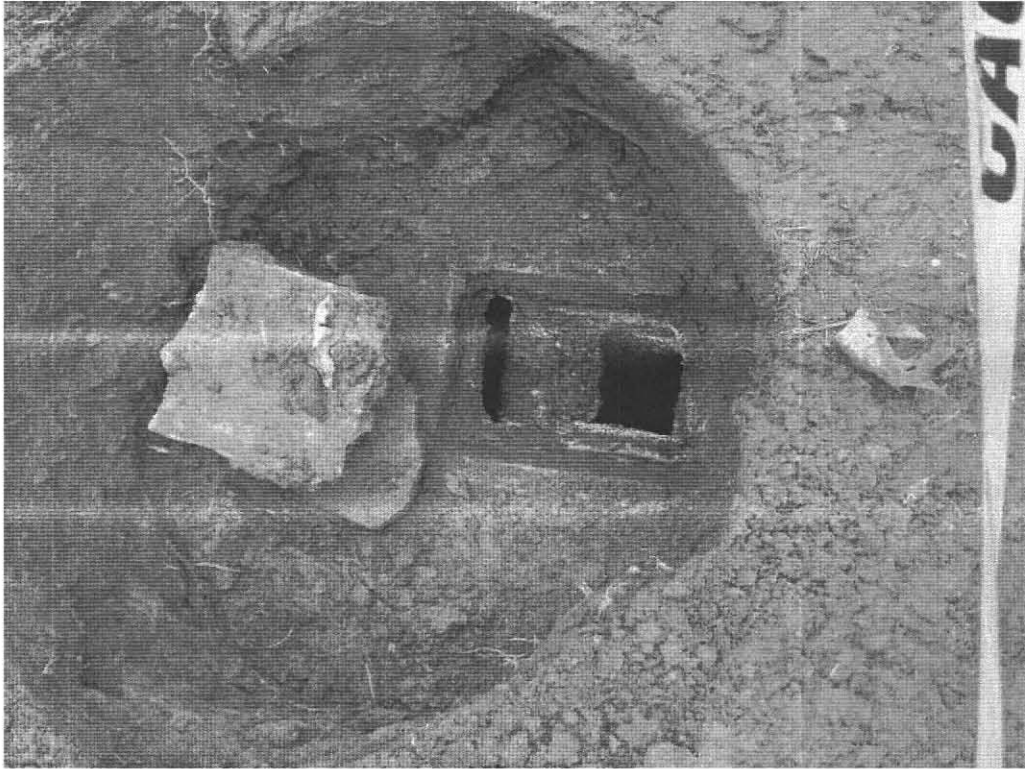
Septic Tank Outlet 7 Trillium Way Amherst, MA 02.02.2012
